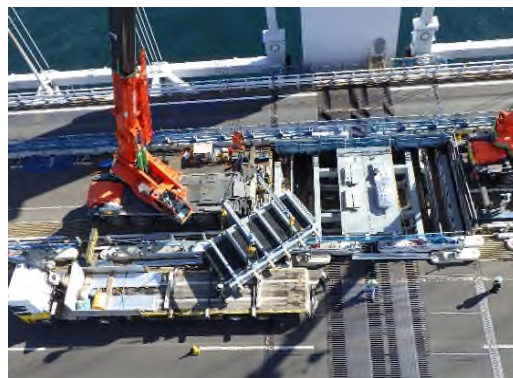
④（新）大型伸縮装置設置作業状況
