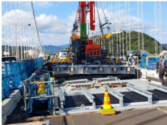
④(新)大型伸縮装置設置作業状況
