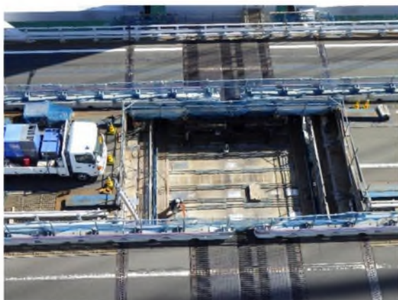
③(旧)大型伸縮装置撤去状況
