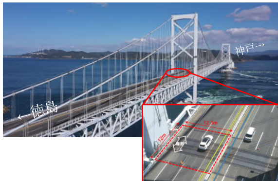
①大型伸縮装置交換箇所
